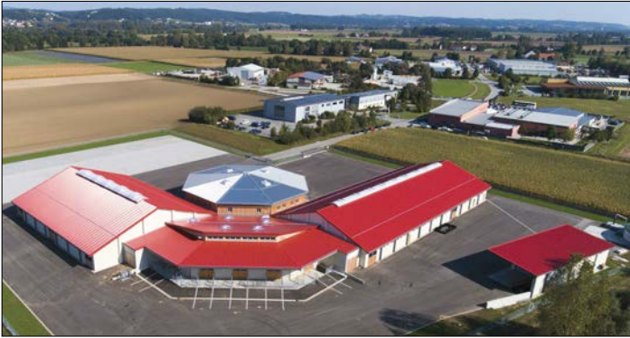
Luftaufnahme der neuen Vermarktungsanlage im Gewerbegebiet Ruckasing bei Osterhofen.
