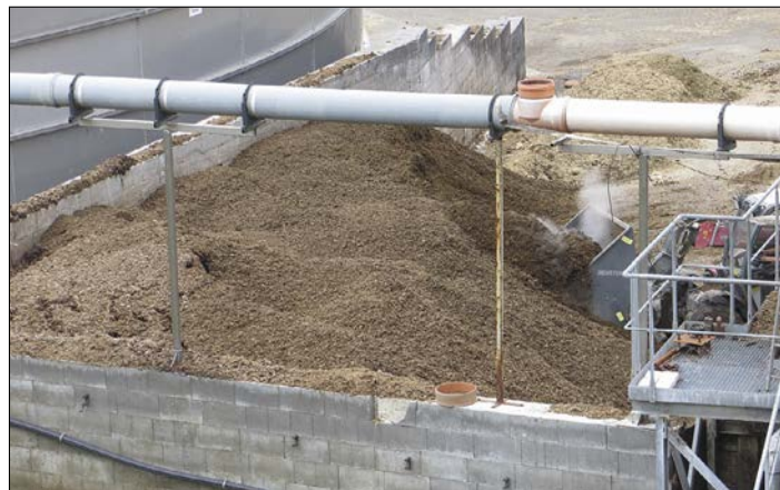
Die Gülleseparierung neben der Biogasanlage.
